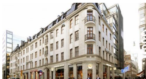
Fastigheten Jericho 34. Bild från Fastighetsnytt.
