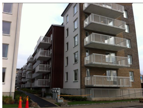
Brf Östra Åkanten fastighet i Kviberg
